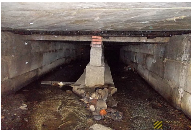
Рисунок 5. Выход подземного коллектора реки Лесопилки. Современное состояние
