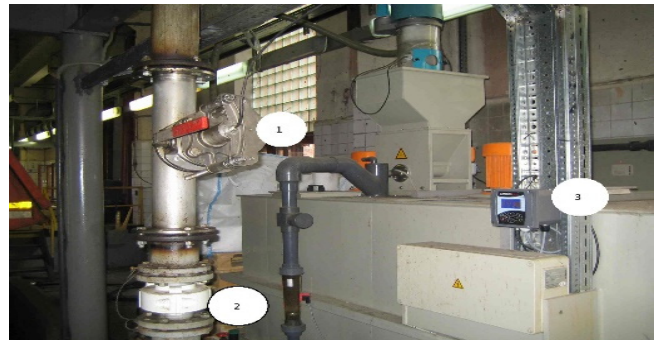
Рис.6. Элементы системы контроля содержания сухих веществ в осадке.
