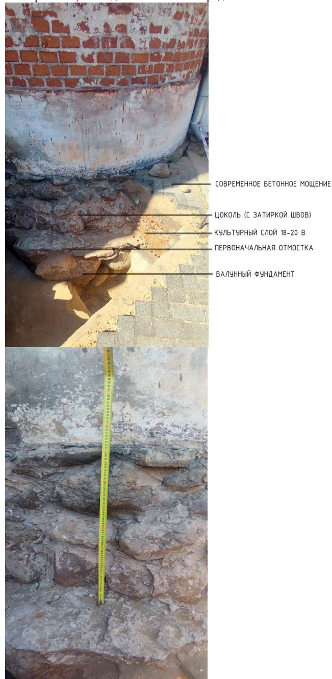
Рис. 6. Фотографии Шурфа №3 восточного фасада. Отмечена первоначальная граница отмостки и отметка поверхности земли на период строительства каменной Казанской церкви в конце 17в.
