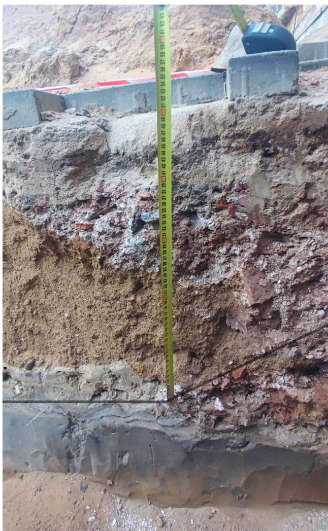
Рис. 5. Фотографии Шурфа №2 северного фасада. Отмечена первоначальная граница отмостки и отметка поверхности земли на период строительства каменной Казанской церкви в конце 17в.
