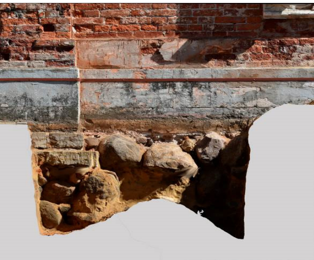
Рис. 2. Ортофотоплан (вид на стену) Шурфа №4 южного фасада.
