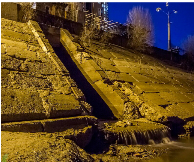
Рисунок 3. Река Плюснинка. Выход подземного коллектора в зоне впадения в р. Амур. Современное состояние
